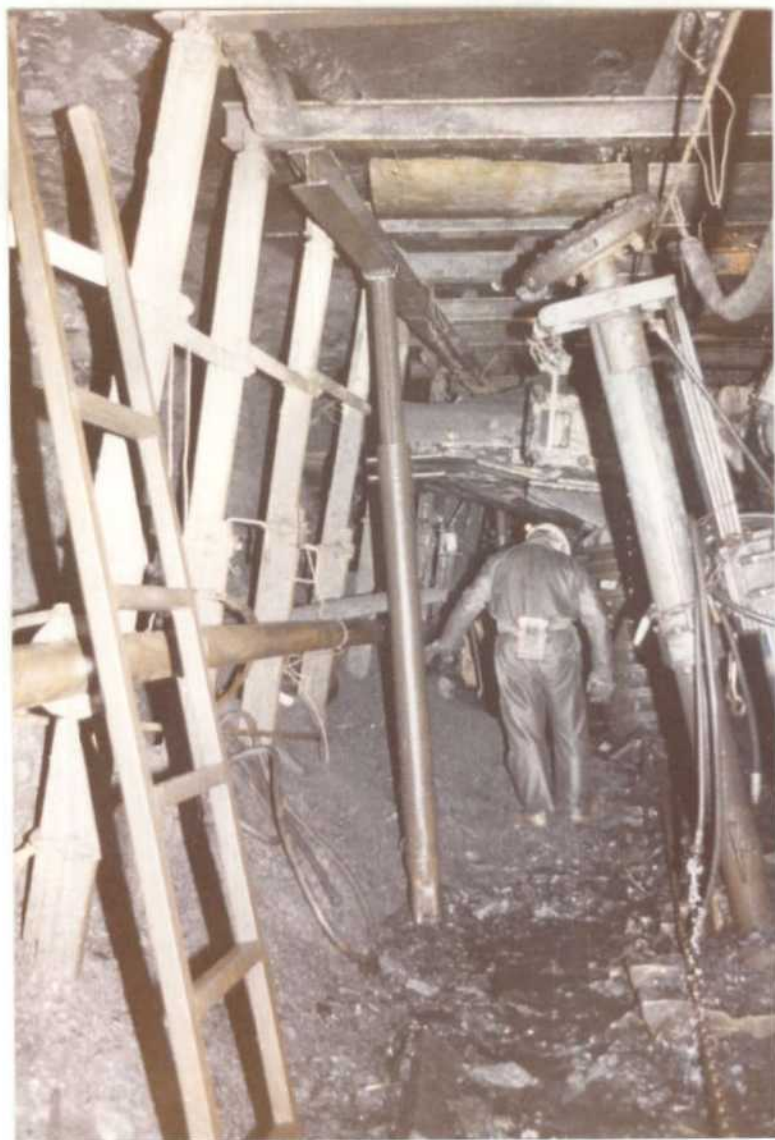
FOTOGRAFIA N° 7 SOSTENIMIENTO PORTANTE TRANSITORIO PARA PERMITIR EL PASO DEL TRANSPORTADOR DEL TAJO.
