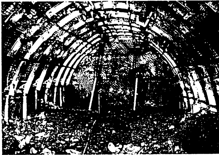
b/ Colocación al avance de galería
